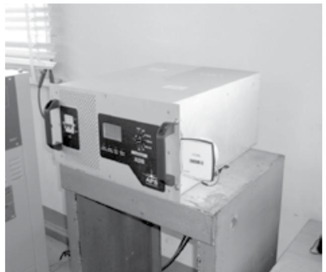
**Fig.1** Equipo APS acondicionado con un horometro instalado en AASANA
