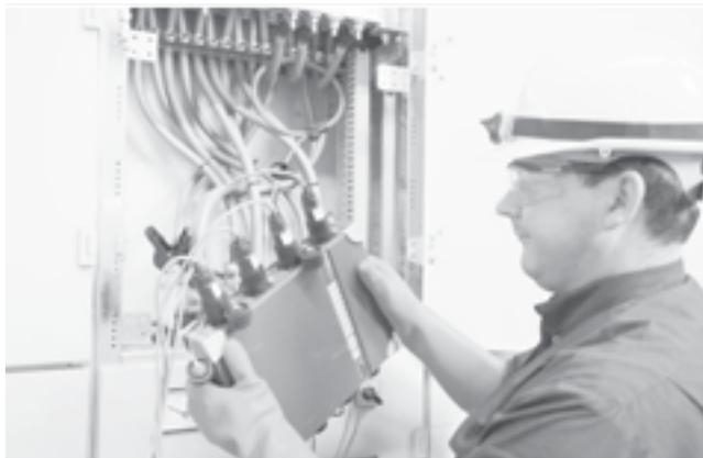
*Configurando el equipo Fluke 1760 para el registro de parámetros a largo plazo*
