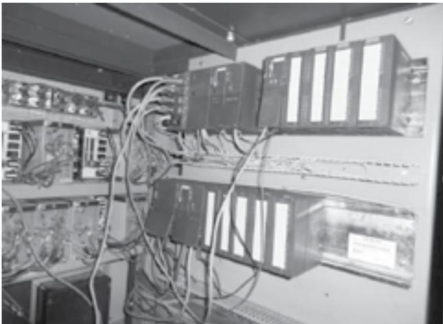
**Fig. 4.** Instalación de Autómatas programables, migración y cambio tecnológico de sistemas de control.
