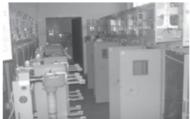
**Fig. 2.** Mantenimiento de interruptores de Media Tensión 6.6KV
