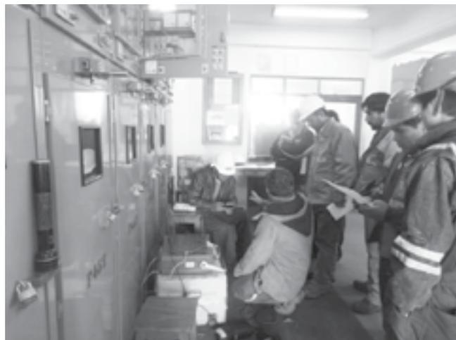
**Fig. 7.** Pruebas de campo de los relés de protección, conforme el estudio de la coordinación de protección S/E EGSA
