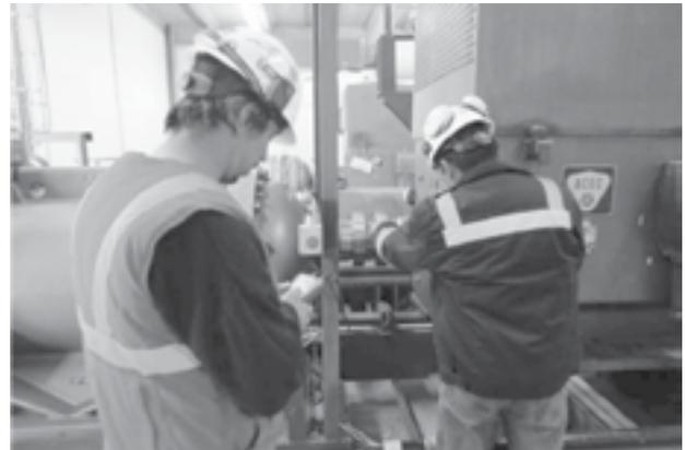
**Fig. 1.** Diagnóstico de alineación de ejes motor-compresor.
