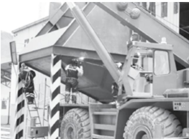
**Fig. 5.** Instalación y montaje de sistema de descargas de concentrados.
