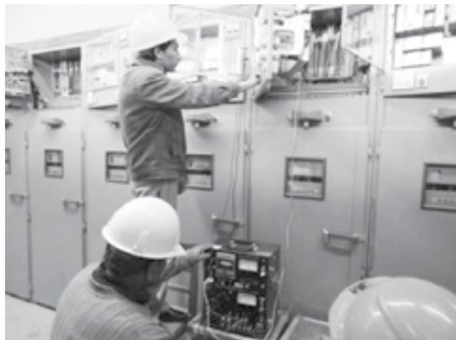
**Fig. 6.** Ajuste de los relés de protección en celdas de MT de CMK.
