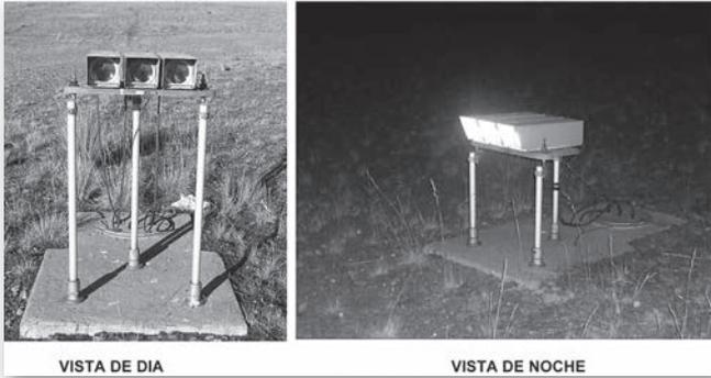
**Figura 8.** PAPI marca PHILIPS - Unidad Lumínica con tres Sistemas Ópticos.
