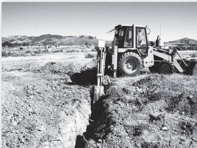
Posterior al estudio de suelos y determinación del emplazamiento, paralelamente a la ejecución de las obras civiles se instaló el sistema de aterramiento.
