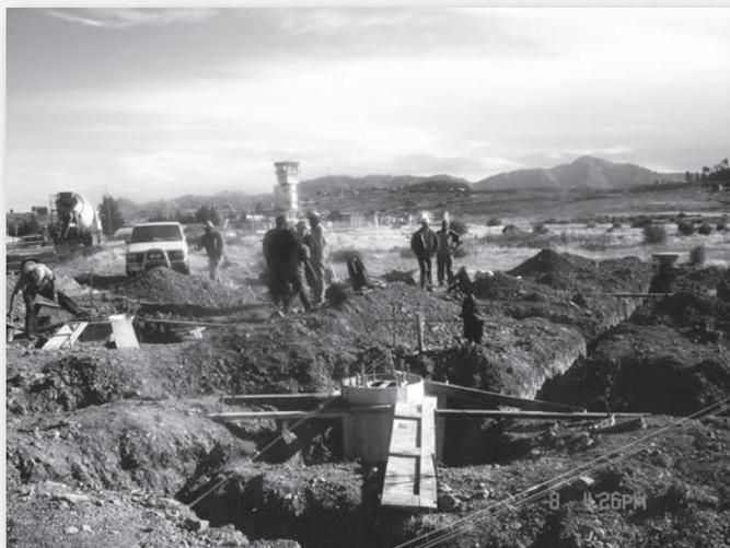
En 24 abril del presente, se inicio el armado de la contraantena, estructura de 30 metros de diámetro y peso de 20 toneladas.
