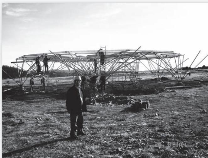
La base o contra-antena que soporta al conjunto de antenas del sistema DVOR/DME está construida de acero inoxidable, galvanizado de gran resistencia a la humedad y corrosión capaz de soportar la carga de viento máxima especificada así como el peso de la estructura y las antenas.
